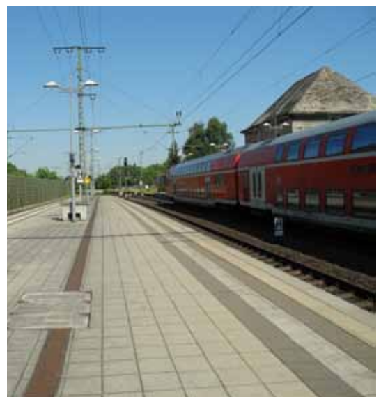
ABB 077 Bahngleise Lehrter Bahnhof Quelle: Stadt Lehrte
