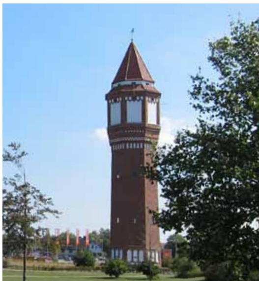
ABB 012 Stadtbildprägender Wasserturm Quelle: SSR
