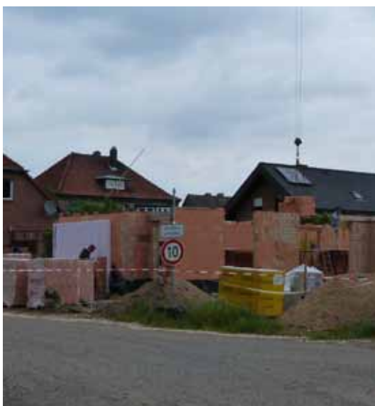
ABB 025 Neubautätigkeiten in Immensen Quelle: SSR
