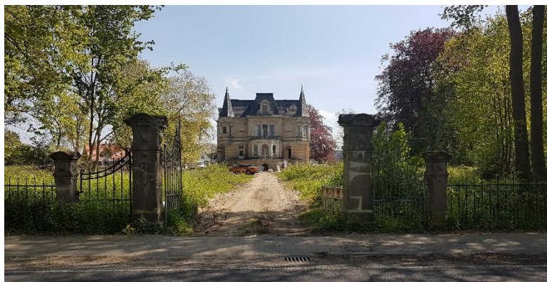
Abb. 3: Zufahrt zur Villa Nordstern von der Itener Straße, April 2020, planerzirkel
