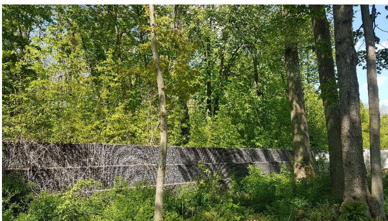
Abb. 4: Gabionenwand entlang der Itener Straße, April 2020, planerzirkel
