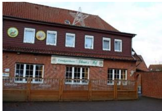
Abb. 3.2: Baudenkmal Scheuer's Hof in Immensen
