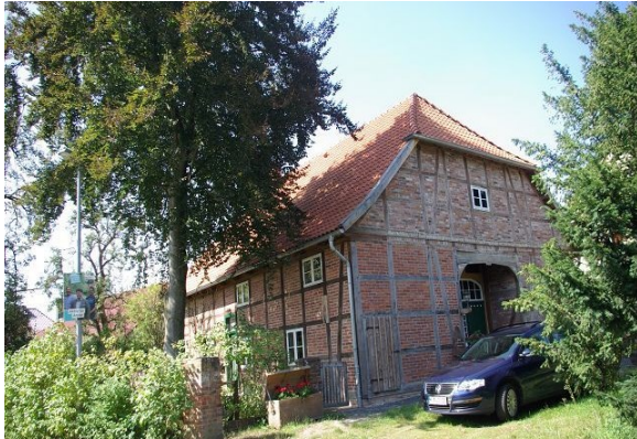
Abb. 7-6 Fachwerk mit Ziegelausmauerung
