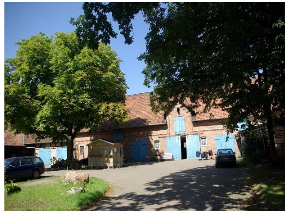
Abb. 4-8 Dreiseitige Hofanlage mit Hofbaum
