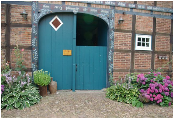
Abb. 7-14 Groot Dör mit Klöntür und Oberlicht zur Belichtung der Diele
