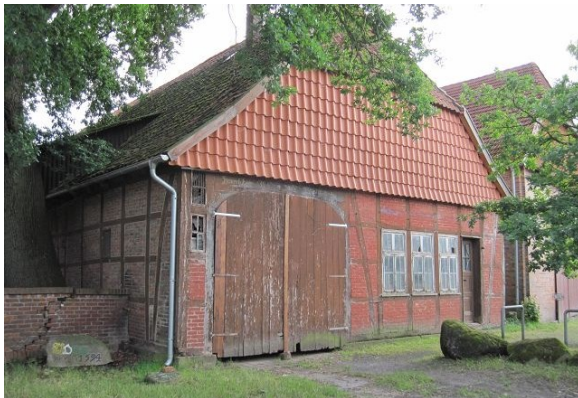
Abb. 7-8 Hangziegel als Wetterschutz
