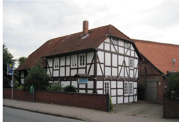
Abb. 7-7 Fachwerk mit verputzten Gefachen
