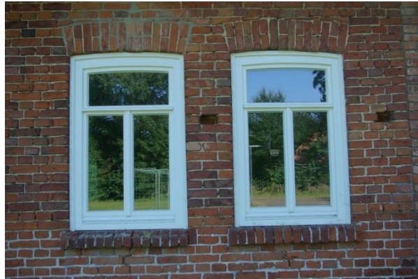
Abb. 7-11 Erneuerte Fenster in Ziegeleigebäude
