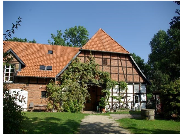
Abb. 4-10 Wohnwirtschaftsgebäude in Sievershausen
