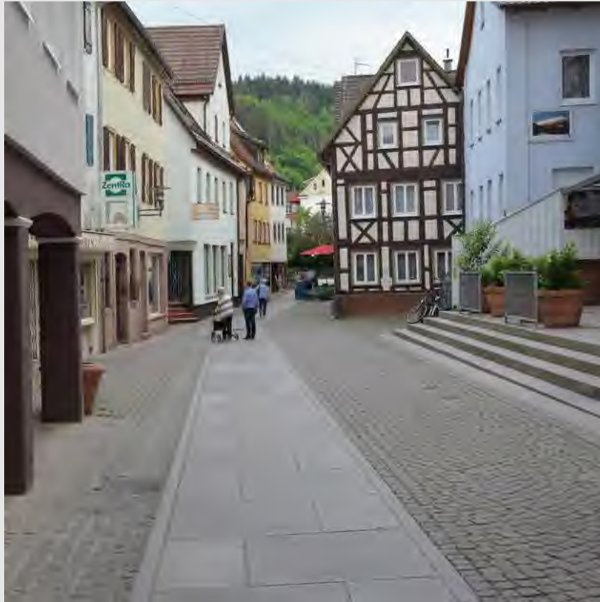
Barrierefreier Oberflächenbelag in Calw, Quelle: Planersocietät
