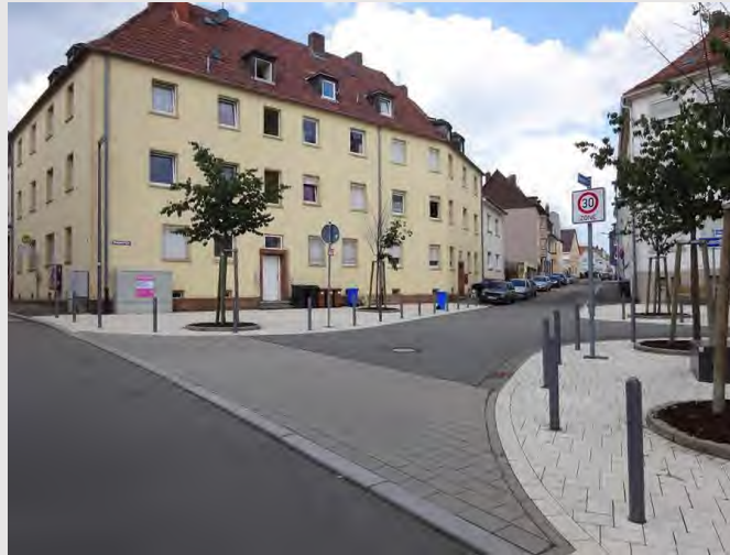
Gehwegüberfahrt in Pirmasens, Quelle: Planersocietät
