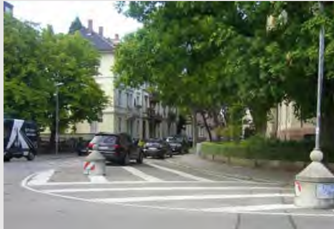
Vorgezogener Seitenraum als einfache Markierung in Freiburg, Quelle: Planersocietät
