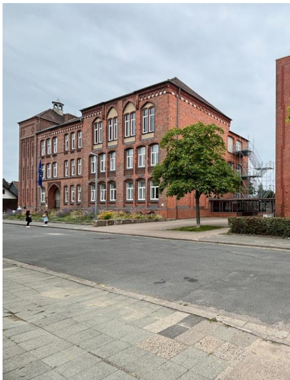
Abb. 13: Baudenkmal Gymnasium im Bestand
