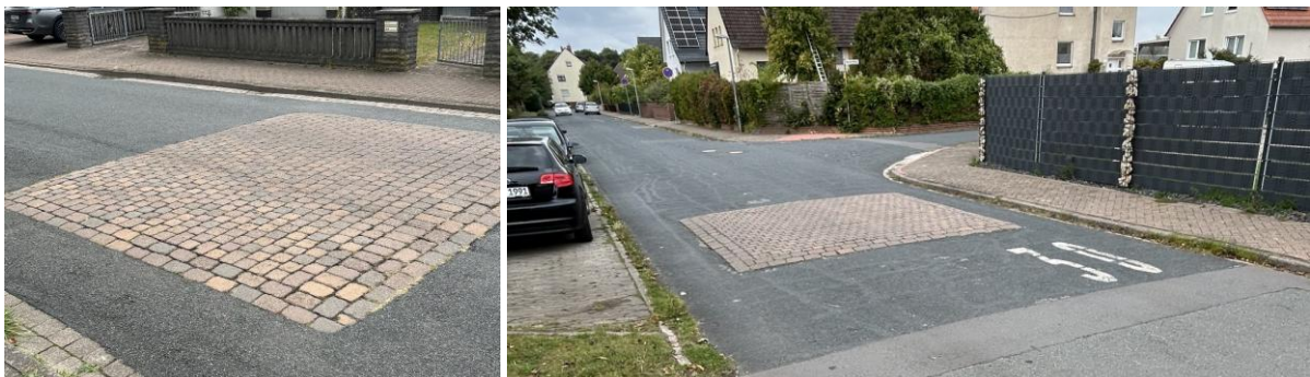
Abbildung 9: Aufpflasterung im Kreuzungsbereich Riedweg/Alter Kirchweg (links) und am Quartierseingang des Starenwegs (rechts)
