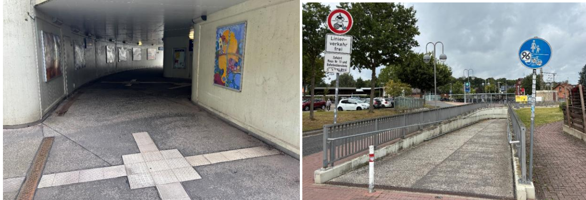
Abbildung 26: Unterführung am Bahnhof (links) und Eingang zur Unterführung Seite Sternstraße (rechts)
